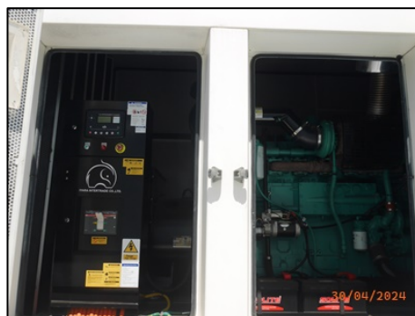
รูปที่ 2.69 เครื่องไฟฟ้าสำรอง
