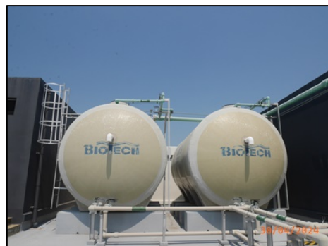
รูปที่ 2.7 ถังเก็บน้ำใต้ดิน จำนวน 2 ถัง และถังเก็บน้ำใช้ชั้นคาตฟ้า
