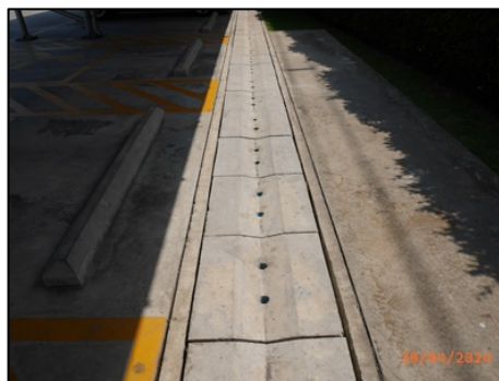
รูปที่ 2.16 รางระบายน้ำฝน ภายในพื้นที่โครงการ
